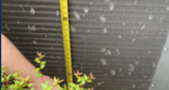
Dents in A/C unit fins
