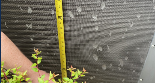
Dents in A/C unit fins
